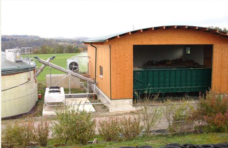
Naßfermentation 195 kW elektrisch
